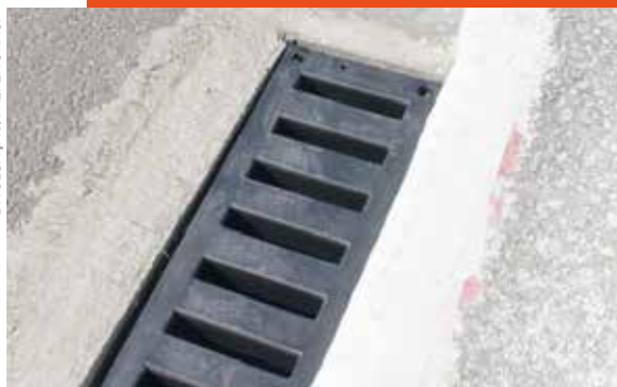
Grelha de plástico instalada na avenida Aricanduva
